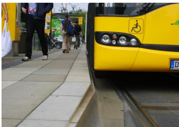
Rys. VII.3.1. Zalecane ukształtowanie krawędzi peronowej.
